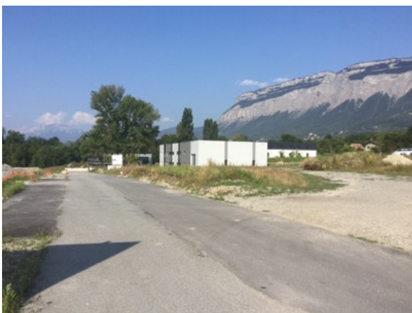
Isiparc, nouvelle zone d'activités tertiaires en construction, Saint-Ismier, juillet 2018
